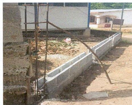
Foto 4: MEJORAMIENTO DE MURO: Se realizo un avance de muro del 40%
