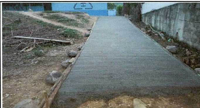
Foto 1: MEJORAMIENTO DE CAMINAMIENTO: Se realizo el caminamiento con un avance del 75%
