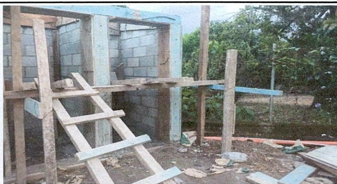
Foto 2: MODULO BAÑO: Se realizo un avance en los baños del 50%
