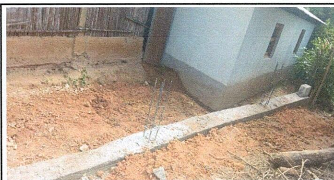
Foto 3: MEJORAMIENTO DE MURO: Se realizo un avance de muro del 20%
